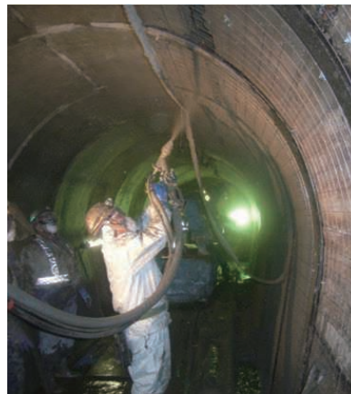
導水路内での吹付け
