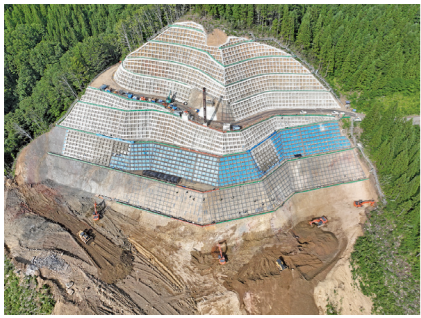
▲斜面を補強して安定化させる工事
