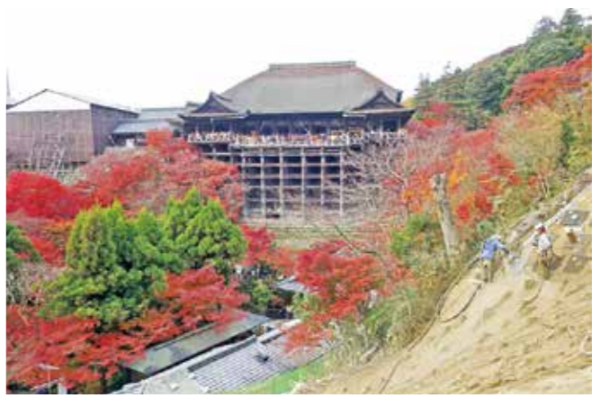
▲ジオファイバー工法により清水寺境内の斜面保護と景観維持に貢献
