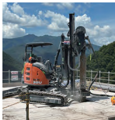
鉄塔基礎 施工状況 (SC-TEPドリル2号機)
