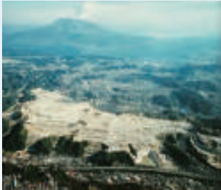
鹿児島市伊敷土地区画整理事業造成工事 1997年
