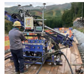
方向・角度を誘導するモニタを見ながらマシンを設置
