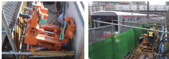
1.5mの幅があれば施工可能
