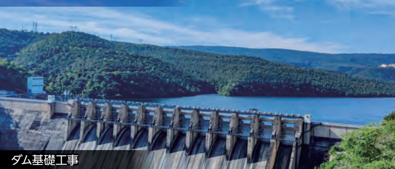
ダム基礎工事
