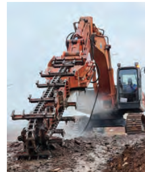
担当工種：地盤改良工
