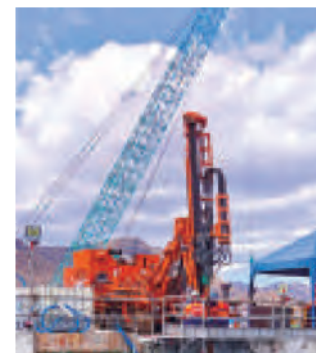
担当工種：グラウンドアンカー工
