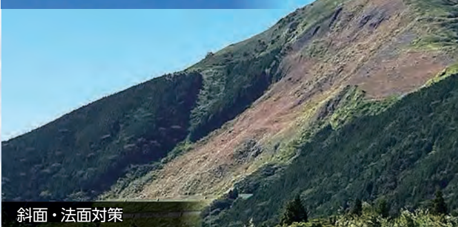
斜面・法面对策
