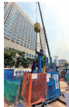
担当工種：地盤改良工
