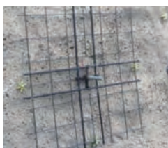
補強部材設置
