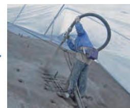
繊維補強モルタル吹付
