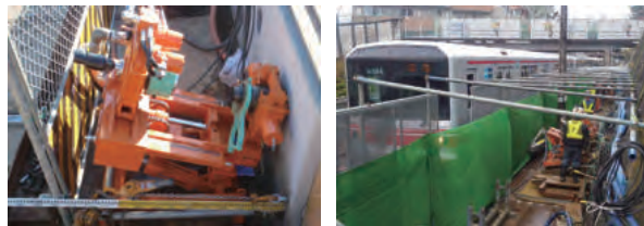
1.5mの幅があれば施工可能
