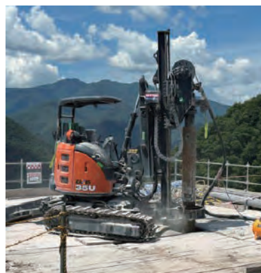
鉄塔基礎 施工状況 (SC-TEPドリル2号機)
