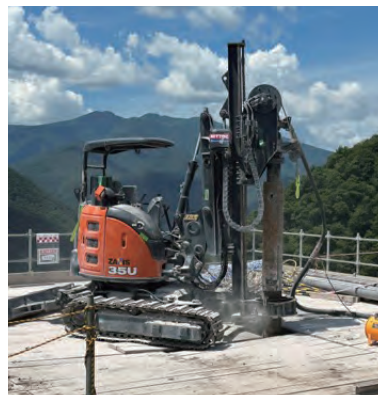
鉄塔基礎 施工状況 (SC-TEPドリル2号機)
