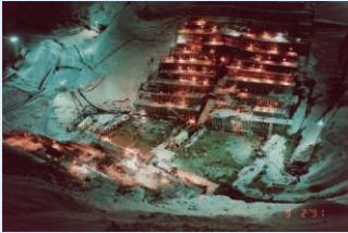
上大須ダム基礎処理工事 1993年
