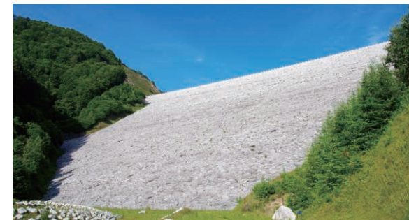
6 長野県 南相木ダム R 堤高：136m
