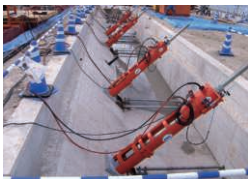
複数アンカーの同時緊張状況
