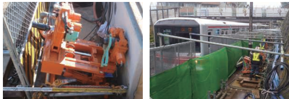
1.5mの幅があれば施工可能
