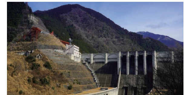
7 奈良県 大滝ダム G 堤高：100m
