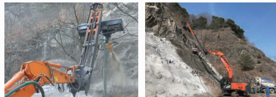
岩盤斜面の吹付状況
