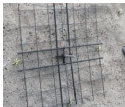
補強部材設置
