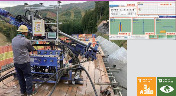
■ 法面削孔技術の高度化・効率化「SGZAs」「ドリルコンパス」 法面削孔技術のマシンガイダンス技術です。GNSSやMEMSセンサなどを活用し、削孔機を設計仕様に応じた位置、削孔方向に正確に誘導します。
