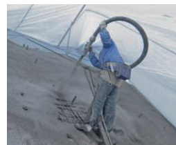
繊維補強モルタル吹付
