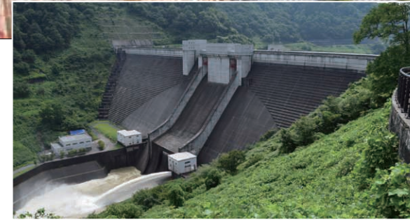
4 山形県 月山ダム GF 堤高：123m
