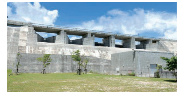
11 沖縄県 金武ダム CSG 堤高：39m
