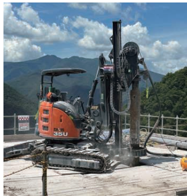
鉄塔基礎 施工状況 (SC-TEPドリル2号機)
