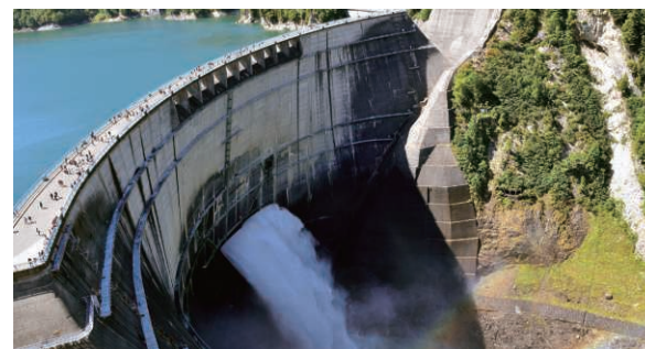
1 富山県 黒部ダム A 堤高：186m
