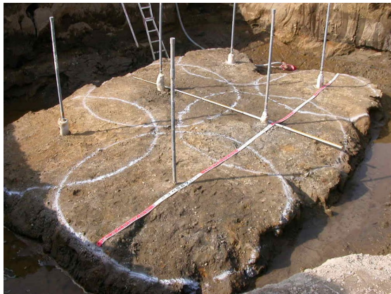
溶液型注入材による改良体の出来形（頭部）
