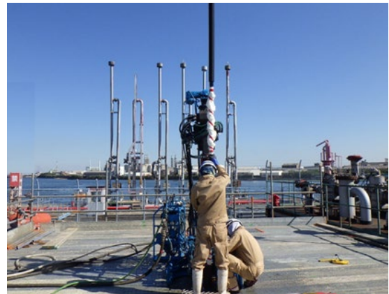
特殊注入外管の建込み状況
