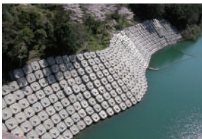
グラウンドアンカー
