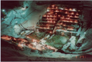
上大須ダム基礎処理工事 1993年
