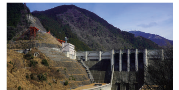
7 奈良県 大滝ダム G 堤高：100m
