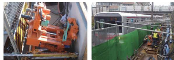
1.5mの幅があれば施工可能
