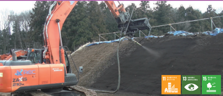
■ スロープセイバーG 遠隔吹付システムを法面緑化工に適用しました。機械化により遠隔から効率よく大規模緑化工が可能です。
