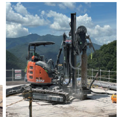
鉄塔基礎 施工状況 (SC-TEPドリル2号機)
