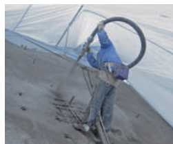
繊維補強モルタル吹付
