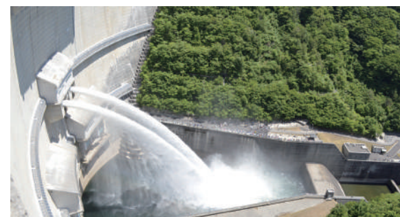
8 広島県 温井ダム A 堤高：156m
