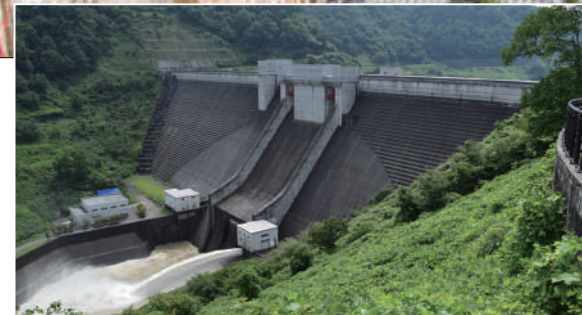
4 山形県 月山ダム GF 堤高：123m
