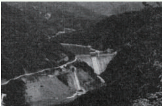
中央進出のきっかけとなった 笹生川ダム建設工事1956-58年施工
