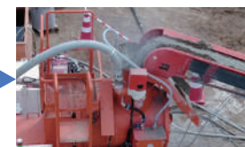
吹付機に自動投入
