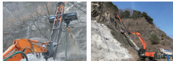
岩盤斜面の吹付状況
