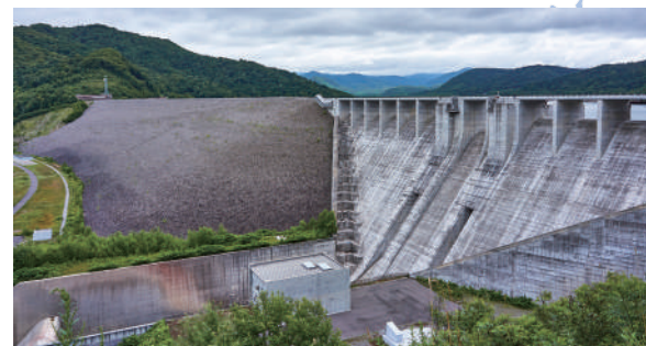
2 北海道 忠別ダム GF 堤高：86m
