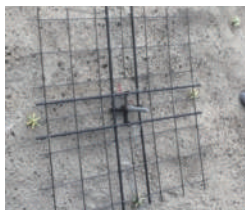
補強部材設置
