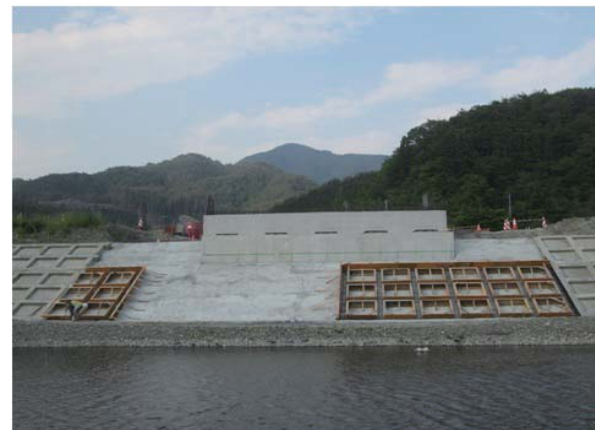
施工中(盛土側面-法枠施工状況)
