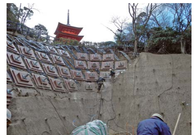
施工中(国重要文化財「子安塔」の下の斜面)
