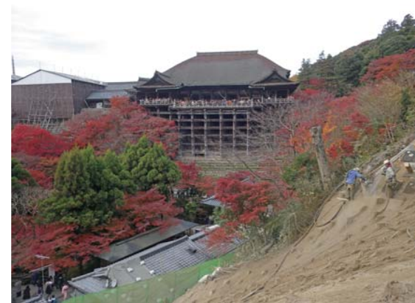
施工中(清水寺の舞台から見える斜面)
