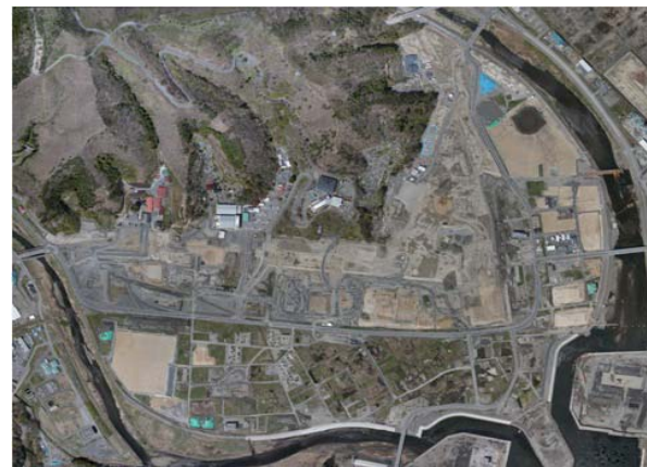
施工中(大槌町 町方地区全景)
