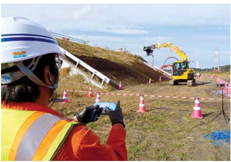
オペレーターが乗り込むことなく 吹き付けを実施
