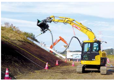
オペレーターが乗り込むことなく 吹き付けを実施
