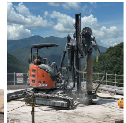
鉄塔基礎 施工状況 (SC-TEPドリル2号機)
