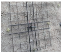
補強部材設置
