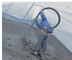
繊維補強モルタル吹付
