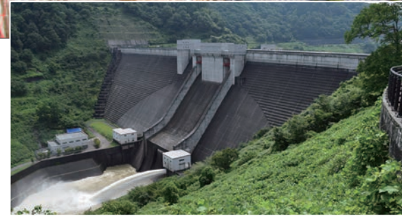
4 山形県 月山ダム GF 堤高：123m
