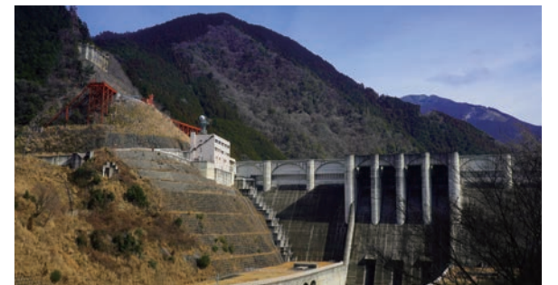
7 奈良県 大滝ダム G 堤高：100m
