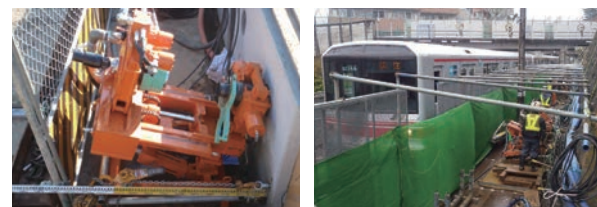
1.5mの幅があれば施工可能
