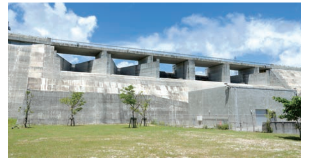
11 沖縄県 金武ダム CSG 堤高：39m
