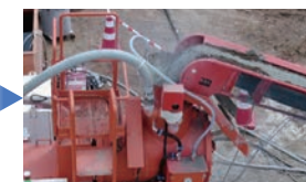
吹付機に自動投入
