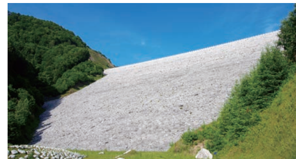
6 長野県 南相木ダム R 堤高：136m
