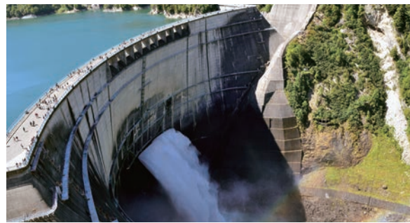
1 富山県 黒部ダム A 堤高：186m
