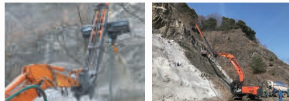
岩盤斜面の吹付状況
