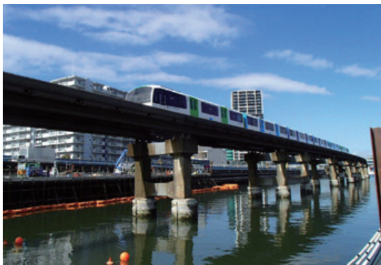
スプリッツアンカー施工中
