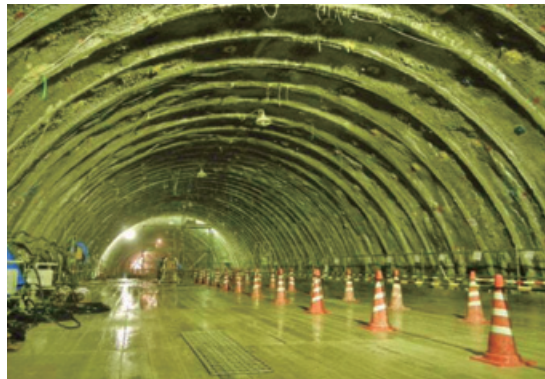
減水対策工実施後の坑内状況
