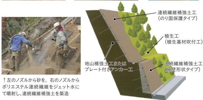
↑左のノズルから砂を、右のノズルからポリエステル連続繊維をジェット水にて噴射し、連続繊維補強土を築造
