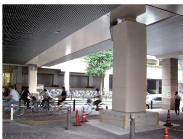
トンネル補修工、橋脚補強工、表面被覆工
