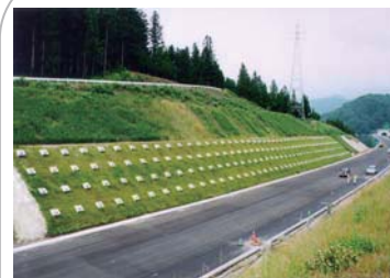
緑化受圧板の使用
