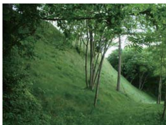
既存木を生かした斜面対策工
