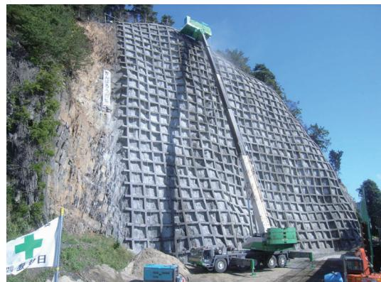
高所作業車を利用したロックボルト工の施工
