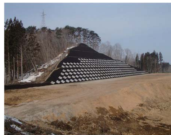
ICの法面のアンカー工施工中
