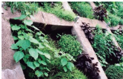
カエルドグリーン工法
