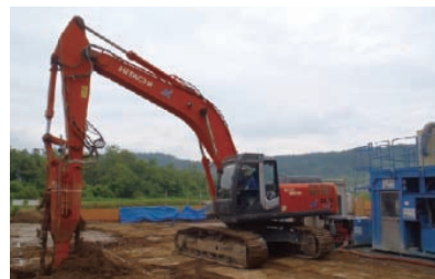
パワーブレンダー工法
