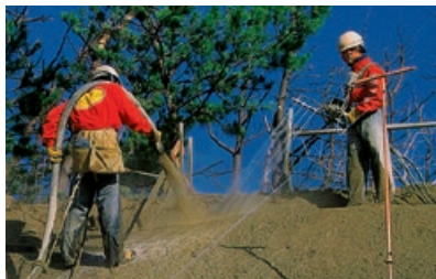
ジオファイバー工法
