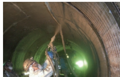
キロ・フケール工法
