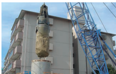
Re.ポーン-パイル工法
