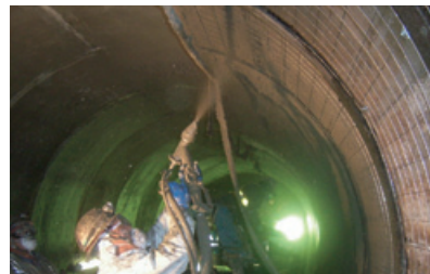
キロ・フケール工法
