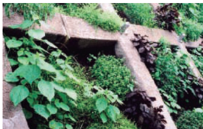
カエルドグリーン工法
