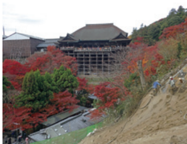
施工中（清水寺の舞台から見える斜面）
