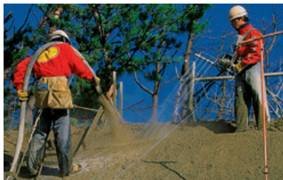
ジオファイバー工法
