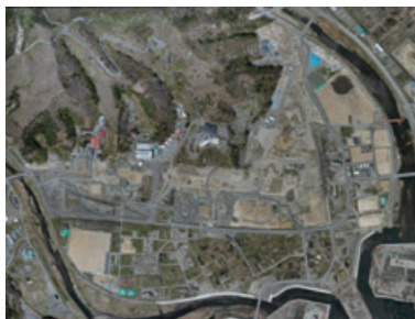
施工中（大槌町 町方地区全景）
