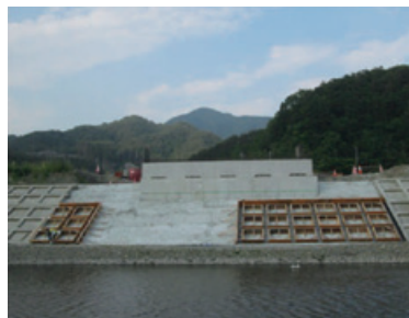
施工中（盛土側面-法枠施工状況）
