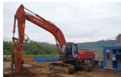
パワーブレンダー工法
