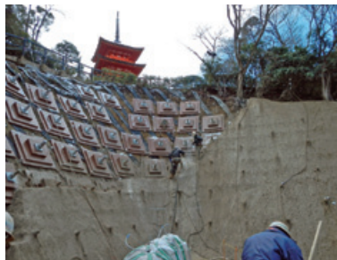
施工中（国重要文化財「子安塔」の下の斜面）
