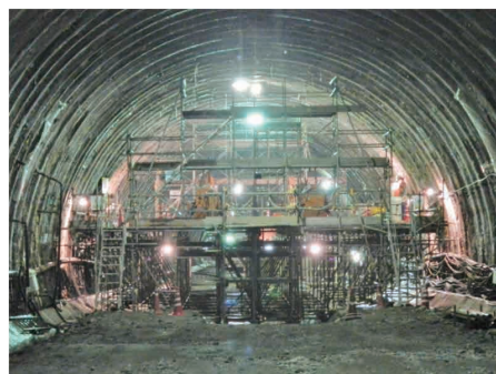
トンネルの止水注入 (鹿児島)
