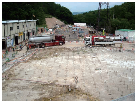
非排水構造トンネルの止水注入 (北海道) (地上からの施工)
