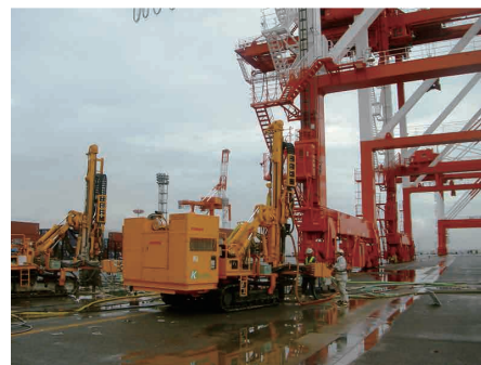
クレーン基礎の耐震補強 (兵庫)
