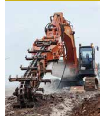
担当工種：地盤改良工
