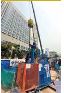
担当工種：地盤改良工
