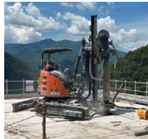
鉄塔基礎 施工状況（SC-TEP ドリル 2 号機）
