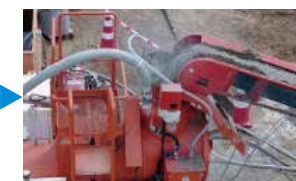
吹付機に自動投入
