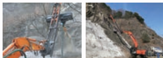
岩盤斜面の吹付状況
