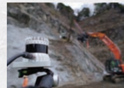
スロープセイバーによる法面吹付。同時にLiDARを使用し、吹付厚さをモニタリング
