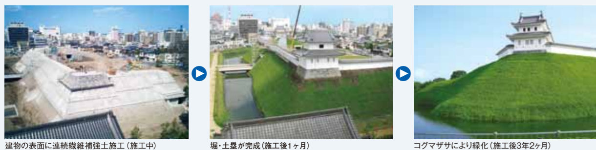
建物の表面に連続繊維補強土施工(施工中) 堀・土塁が完成(施工後1ヶ月) コグマササにより緑化(施工後3年2ヶ月)
