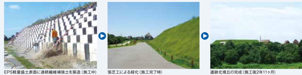
EPS軽量盛土表面に連続繊維補強土を築造(施工中) 張芝工による緑化(施工完了時) 遺跡北墳丘の完成(施工後2年11ヶ月)
