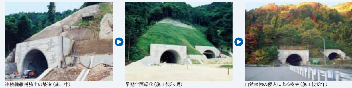
連続繊維補強土の築造(施工中) 早期全面緑化(施工後3ヶ月) 自然植物の侵入による樹林(施工後13年)
