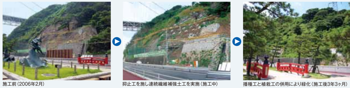
施工前(2006年2月) 抑止工を施し連続繊維補強土を実施(施工中) 播種工と植栽工の併用により緑化(施工後3年3ヶ月)
