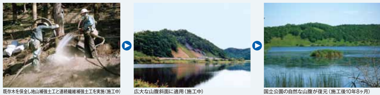
既存木を保全し地山補強土と連続繊維補強土を実施(施工中) 広大な山腹斜面に適用(施工中) 国立公園の自然な山腹が復元(施工後10年8ヶ月)
