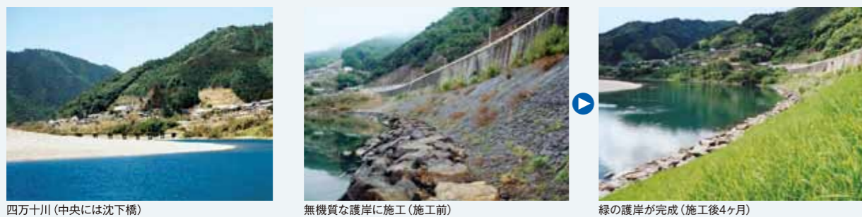
四万十川(中央には沈下橋) 無機質な護岸に施工(施工前) 緑の護岸が完成(施工後4ヶ月)
