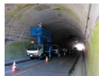
道路トンネルの背面
