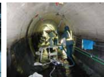
導水路トンネルの背面
