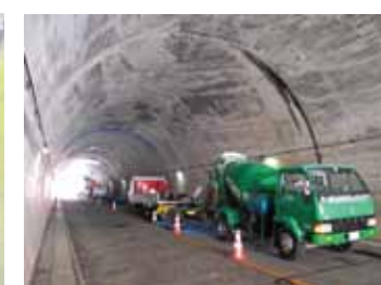
トラミキによる基材運搬
