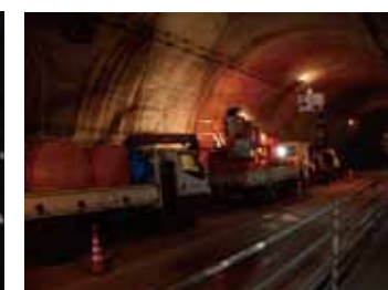
道路トンネルの背面
