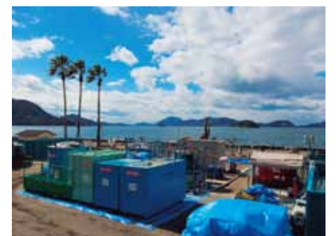
▲施工プラント全景
