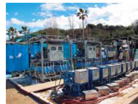
▲注入ユニット
