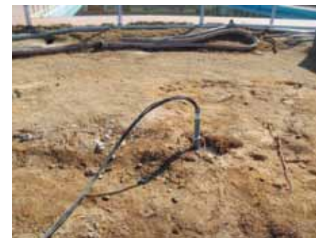
▲注入内管挿入
