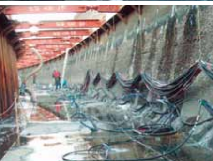
河川を仮締切した 中での注入状況
