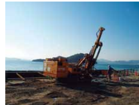
▲削孔は鉛直・斜め・水平にも対応
