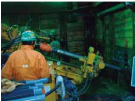
立坑内での 削孔状況
