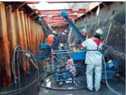
小型ボーリングマシン による削孔状況
