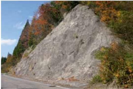
吹付表面がひび割れたり剥がれたりしているだけでなく、背面の地山が風化している可能性があります。
