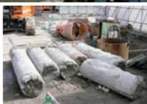
近年、建築物の老朽化が進み、場所打ち杭が多く採用されている昭和40年代以降の建物の解体・建替え工事が増加しています。Re. ボーン - パイル工法は、在来の全周オールケーシング機を使用し、油圧駆動による2枚の切断翼で既存杭や地中構造物を地中で切断・撤去する工法です。
