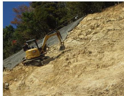
排土工(不安定土塊の撤去)
