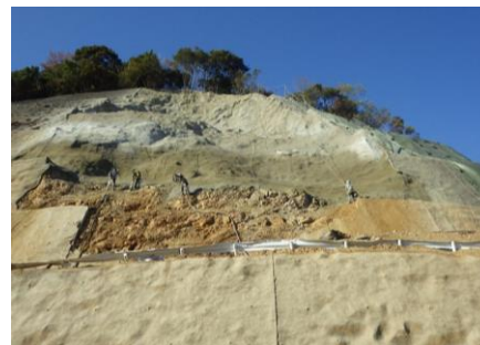
排土工(不安定土塊の撤去)
