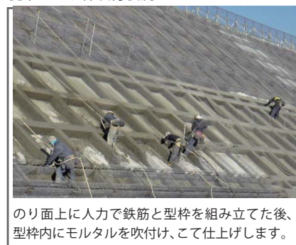
従来ののり砕吹付状況
