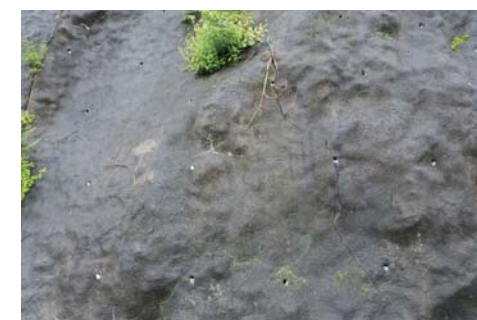
ドローンで撮影したのり面
