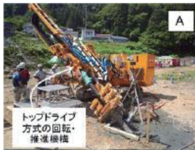
A：斜め施工タイプ
