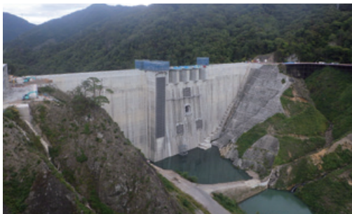
下流側から見たダム本体
