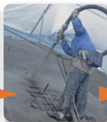
繊維補強モルタル吹付
