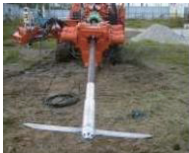
縮翼・拡翼が可能な攪拌装置
