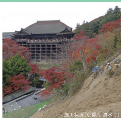
施工状況(京都府 清水寺)
