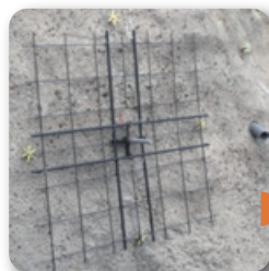
補強部材設置
