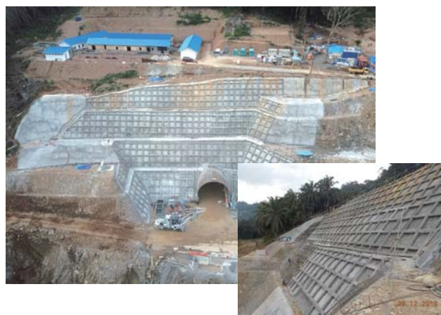
■バリクパパン製油所内のり面工事 RDMP RU-V Balikpapan
