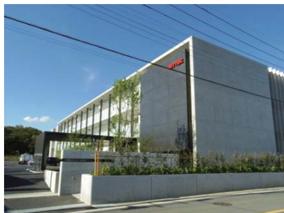
蓮田総合センター外観(正面道路より)
