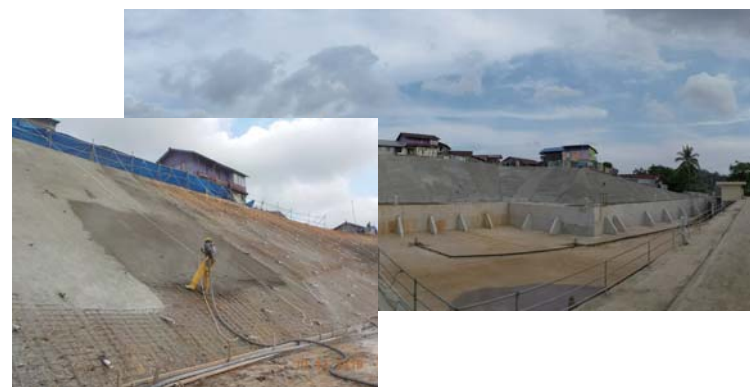
■インドネシア国 中層混合処理工法による地盤改良効果の普及・実証事業 Cement Soil Mixing Demonstration Work
