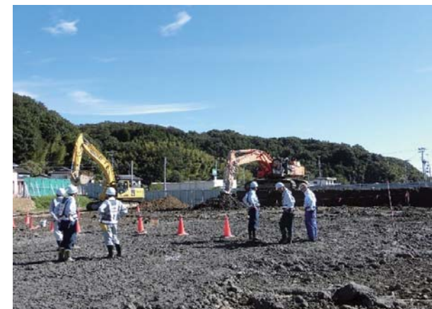
安全パトロールの様子
