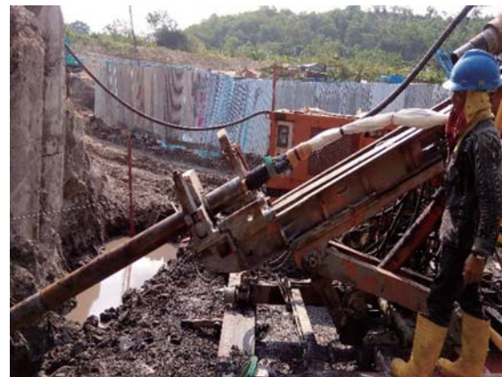
■ ルムットバライ地熱発電所工事 Lumut Balai Geothermal Power Plant Construction
