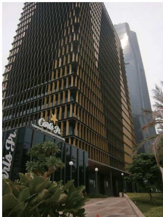
新しいオフィスが入居しているビル GENERALI TOWER
