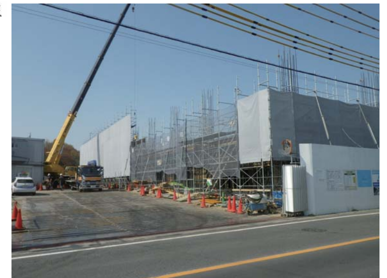
蓮田総合センター建設中の様子
