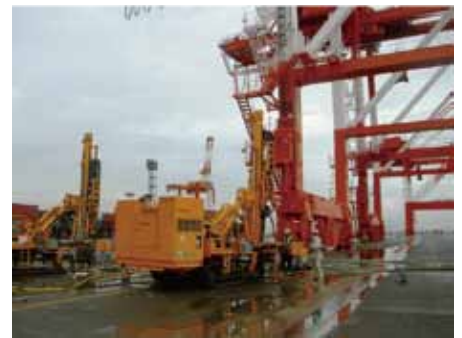
クレーン基礎の耐震補強 (兵庫)
