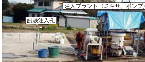
現場注入試験状況
