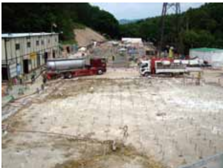
非排水構造トンネルの止水注入 (北海道) (地上からの施工)
