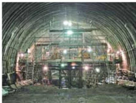
トンネルの止水注入 (鹿児島)
