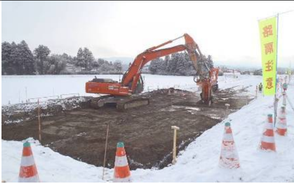
パワーブレンダー工法による堤防の耐震補強
