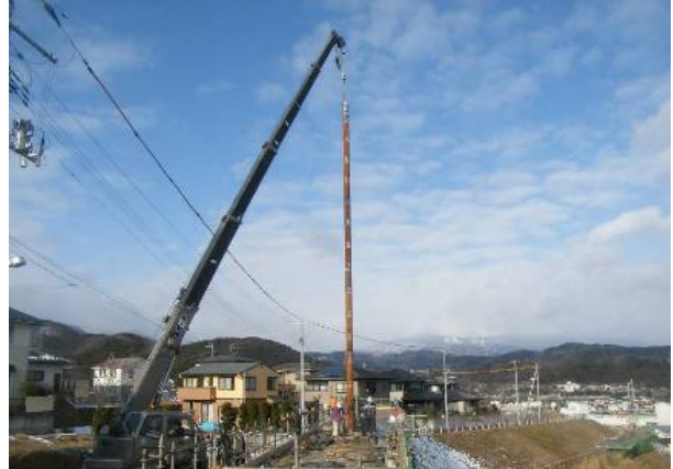
抑止杭工による住宅地の地すべりの復旧・復興
