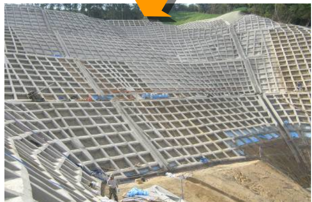
法枠工等による道路法面崩壊の復旧・復興
