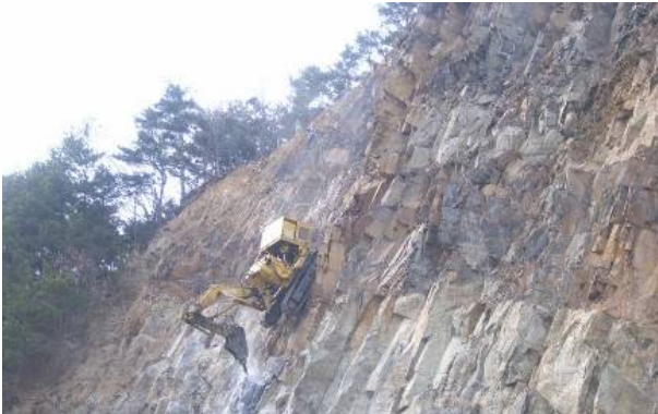
ロッククライミング工法による浮石除去
