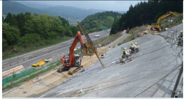
鉄筋挿入工等による道路法面崩壊の復旧・復興
