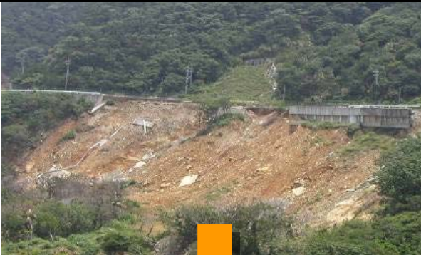
親杭パネル壁工法による道路路肩の復旧・復興
