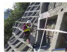
のり面展開図を作成し、CAD図に変換
