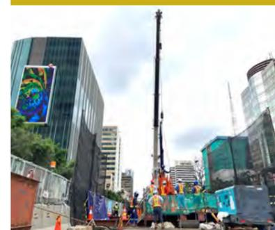
ジャカルタ都市高速鉄道（地下鉄）工事において、ジェットグラウト工法によりシールドマシンの発進・到達立坑の地盤改良を行っています。
