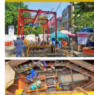
市街地における下水施設整備のため、非開削技術である泥水式推進工法を用いて周辺交通への影響を低減しています。
