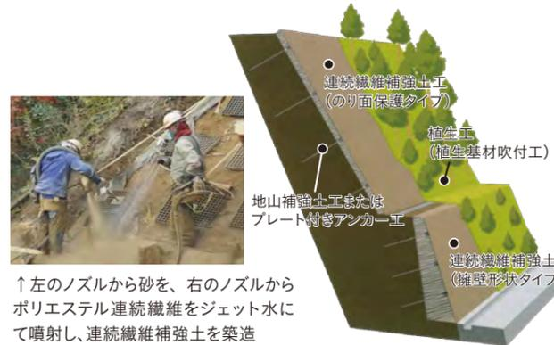
↑左のノズルから砂を、右のノズルからポリエステル連続繊維をジェット水にて噴射し、連続繊維補強土を築造
