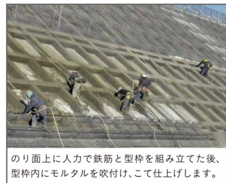
のり面上に人力で鉄筋と型枠を組み立てた後、型枠内にモルタルを吹付け、こて仕上げます。
