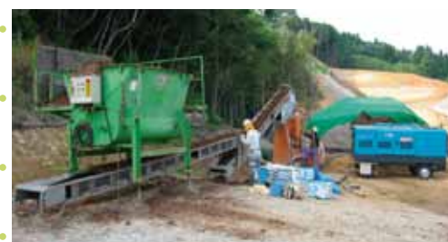
▲植生基盤材の現地作製
