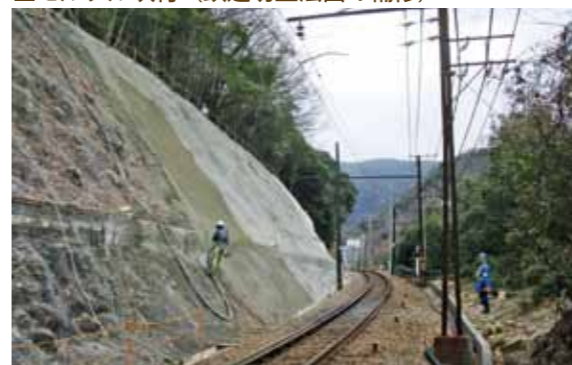
■モルタル吹付（鉄道切土法面の補修）
