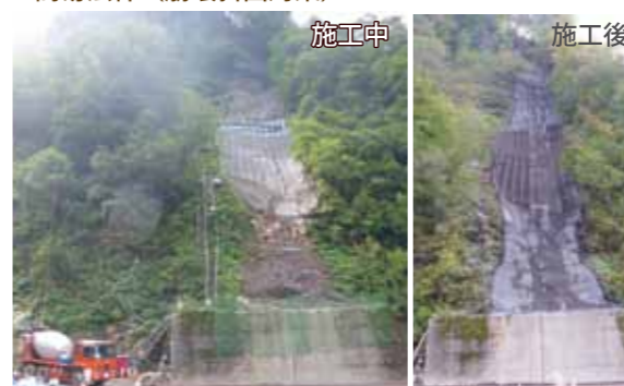
■モルタル吹付（鉄道切土法面の補修）
