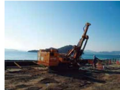
▲削孔は鉛直・斜め・水平にも対応
