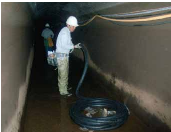
写真-1 坑外から 1.5 インチホースで材料を 900m 圧送し、導水路トンネル坑内の素掘り部へ吹付（鹿児島県）
