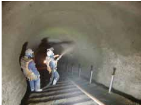
写真-7 下り坂での吹付作業
