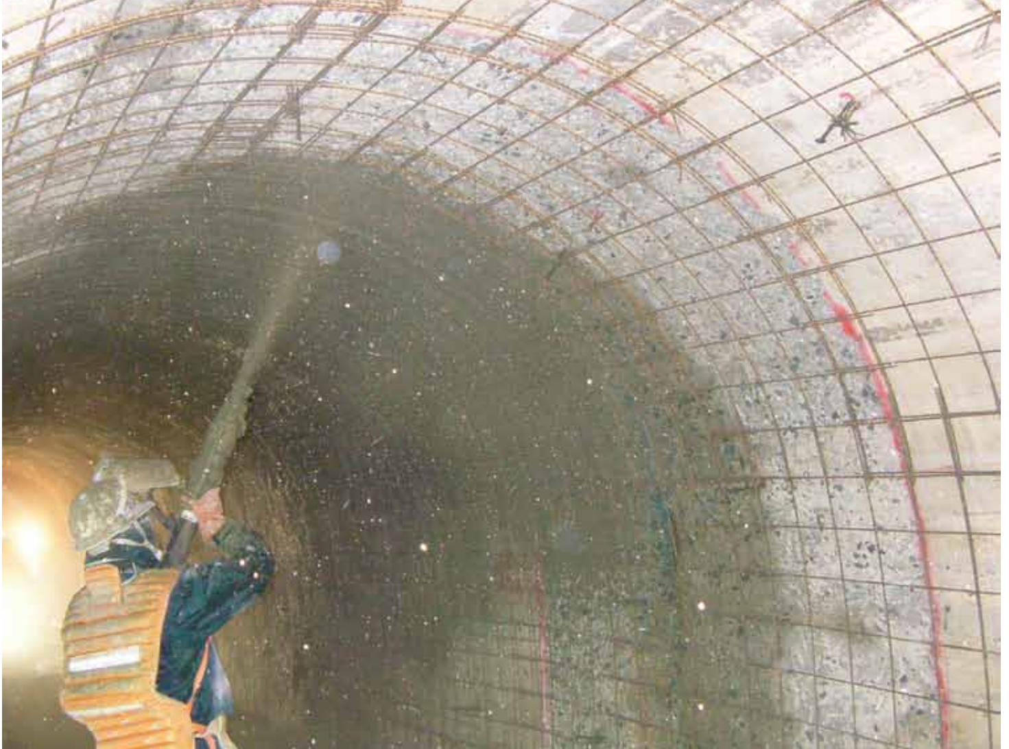
写真-1 内空断面の小さな歩行者専用トンネル坑内での、高強度繊維補強モルタル吹付作業（山口県・秋芳洞）
