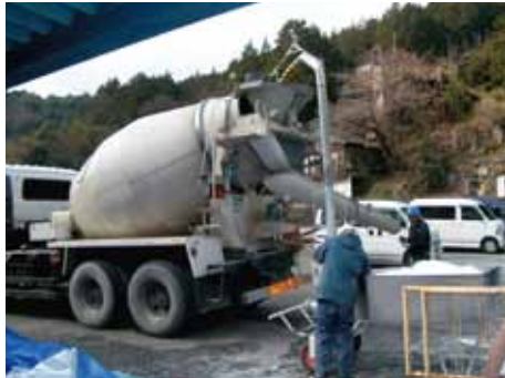
写真-4 工場練モルタルに BC ファイバー投入
