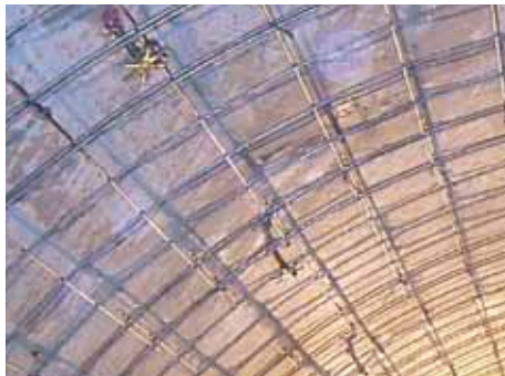
写真-6 剥落防止に「せん断ボルト」を設置
