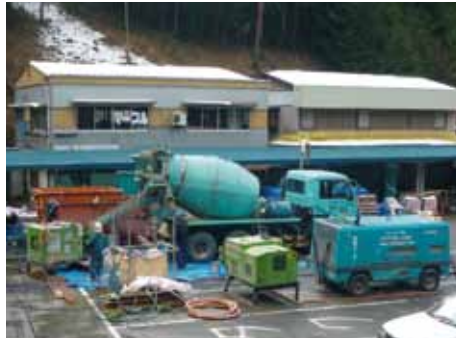
写真-3 観光客用駐車場に整然と並ぶ施工機械
