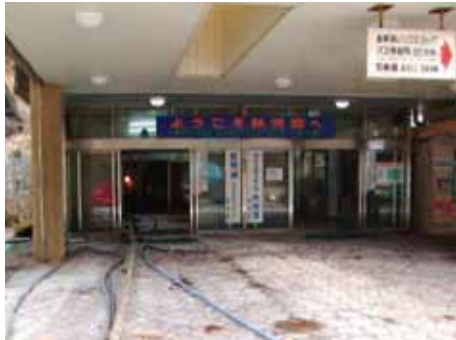
写真-5 材料は玄関を通過してトンネル坑内へ
