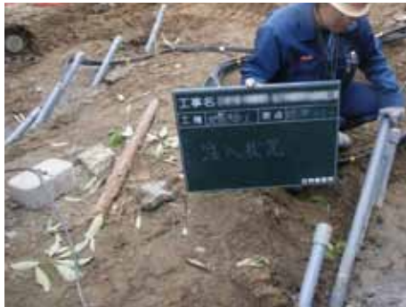
写真-2 エキスパッカ-N工法による地盤注入
