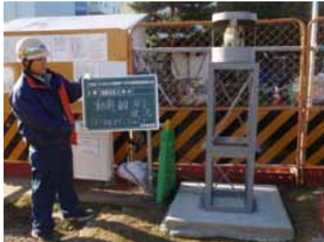
写真-3 トータルステーション設置状況
