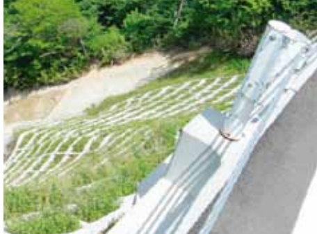
写真-3 天端状況（オーレン）
