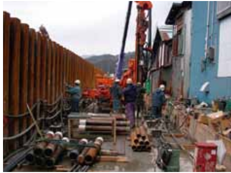
写真-3 仮設堤防と民家の狭間で施工 (H19)
