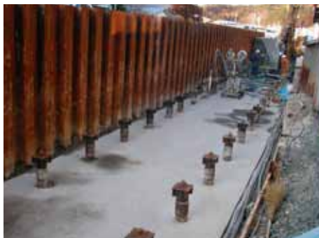
写真-5 小口径杭施工完了 (H19)
