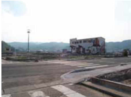
写真-7 堤防の周囲は壊滅的 (H23.6.29)
