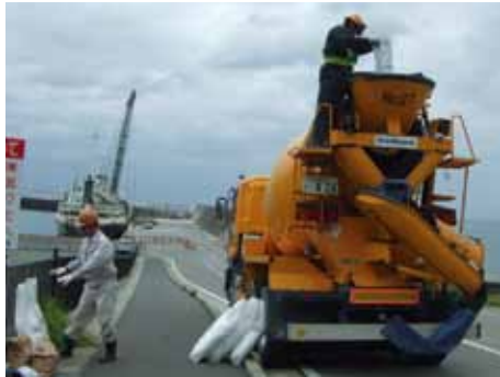
写真-3 生コン車にBCファイバーを直接投入
