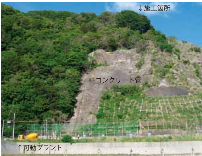
写真-1 道路から直高 110m 上方の林の中で、木を残したまま不安定岩塊に繊維補強モルタルを吹付（静岡県西伊豆）
