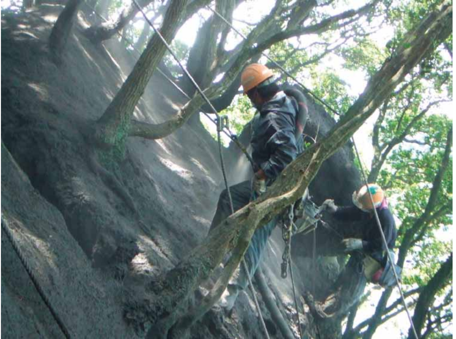
写真-1 道路から直高 110m 上方の林の中で、木を残したまま不安定岩塊に繊維補強モルタルを吹付（静岡県西伊豆）
