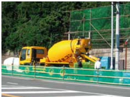
写真-5 可動プラントは路側帯に配置
