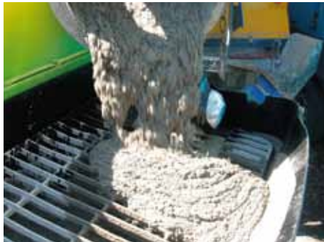
写真-4 BCファイバーは均一に分散している
