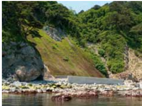
写真-4 施工後の斜面は緑に (H22.6.26)
