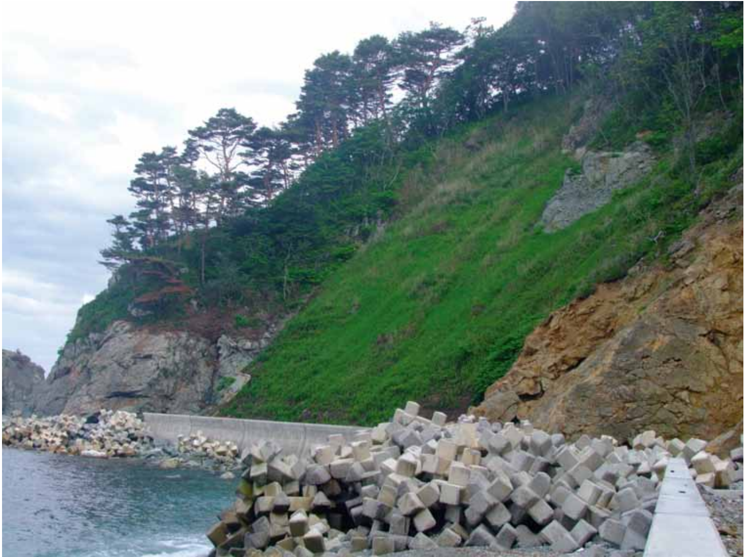
写真 -1 地震の揺れと津波のなか、崩壊を免れたジオファイバー工法施工面（岩手県久慈市三崎）
