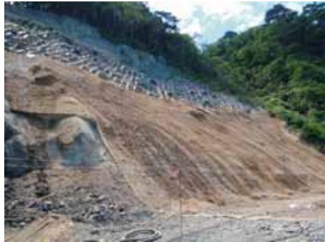
写真-3 連続繊維補強土の施工 (H21.8.26)
