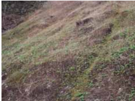
写真-7 法面表面の状況 (H23.5.10)
