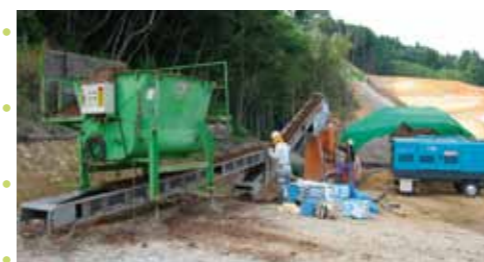
▲植生基盤材の現地作製
