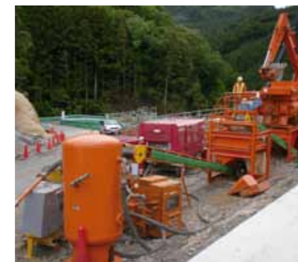
▲施工プラント例
