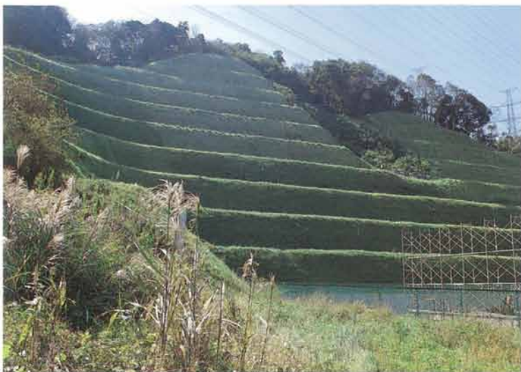
修景緑化された法面(昭和57年)
