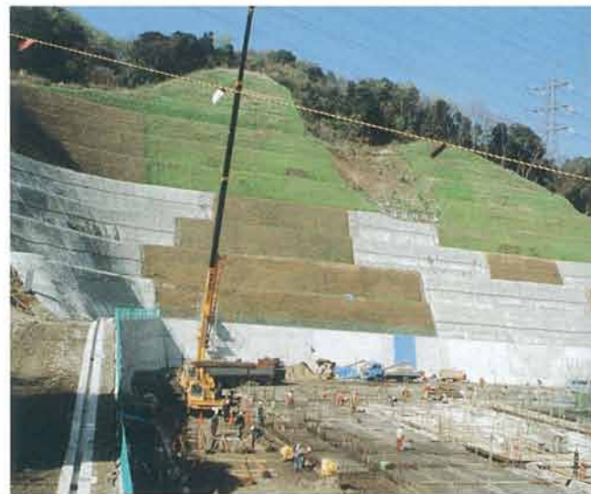
コンクリート法面への緑化工施工(昭和56年)
