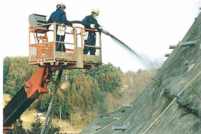
SFRC吹付け状況
