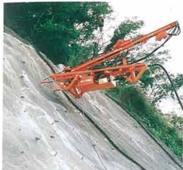
吊下げ式穿孔機による補強鉄筋工
