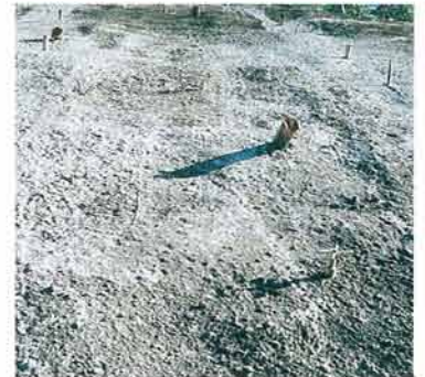
水抜パイプ・検測ピンの設置
