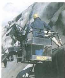
空隙注入工
