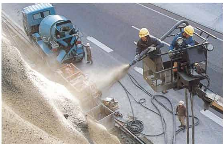
コンクリートポンプ吹付け機によるSFRC吹付け状況
