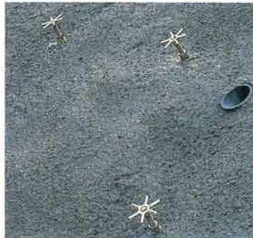
せん断ボルト工
