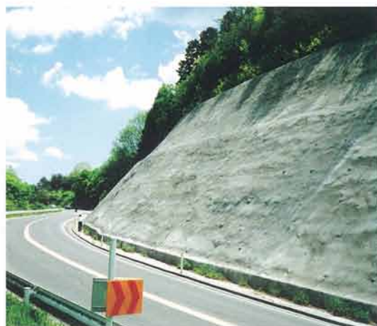
3年経過した法面状況(平成6年)
