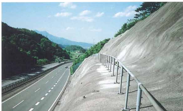
10年経過の法面は変状が見られない(平成6年)
