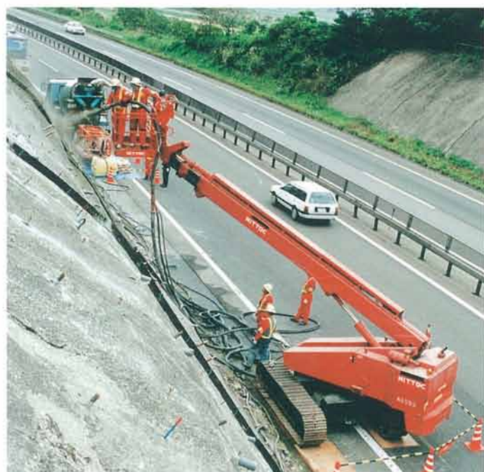
日本道路公団 東北自動車道安達越河地内法面補修工事(宮城県)―平成6年
