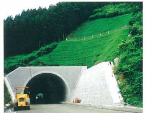
景観保全対策として既設コンクリート法面を緑化
