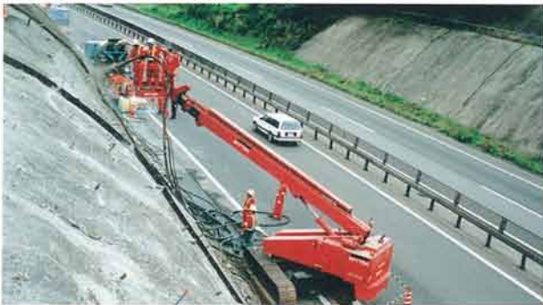
高所作業車によるSFRC吹付け工
