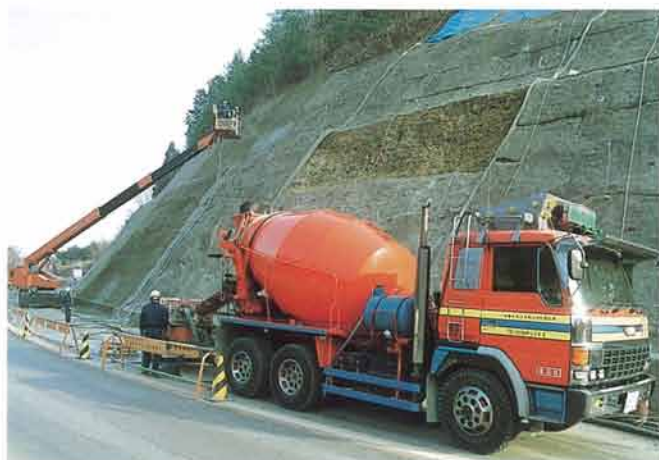
高所作業車による吹付け状況(平成3年)
