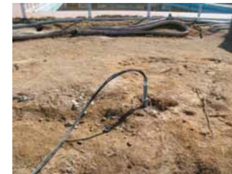
▲注入内管挿入
