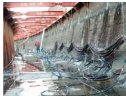
河川を仮締切した中での注入状況
