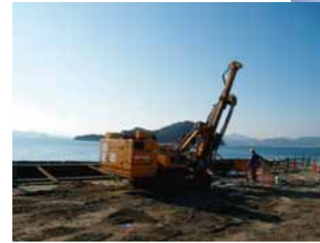
▲削孔は鉛直・斜め・水平にも対応
