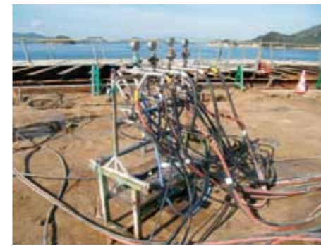
▲ダブルパッカ操作装置
