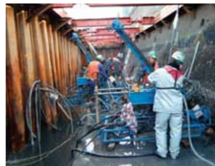
小型ボーリングマシンによる削孔状況
