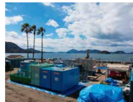
▲施工プラント全景
