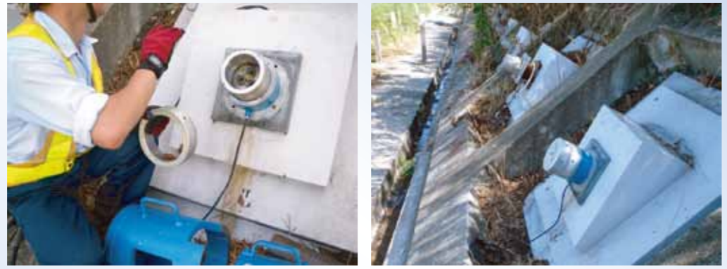
スーパーフロテックアンカーへの荷重計取付け
